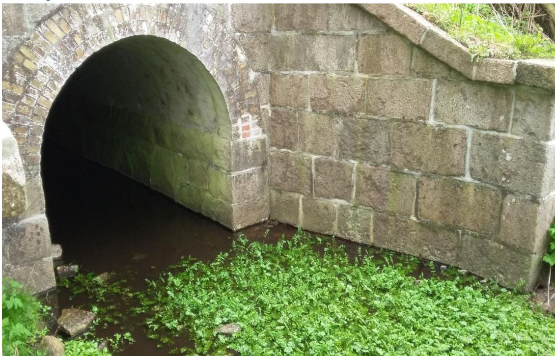
Foto nr. 8. Foto viser viadukten af håndhuggede sten, som fører under jernbanen
